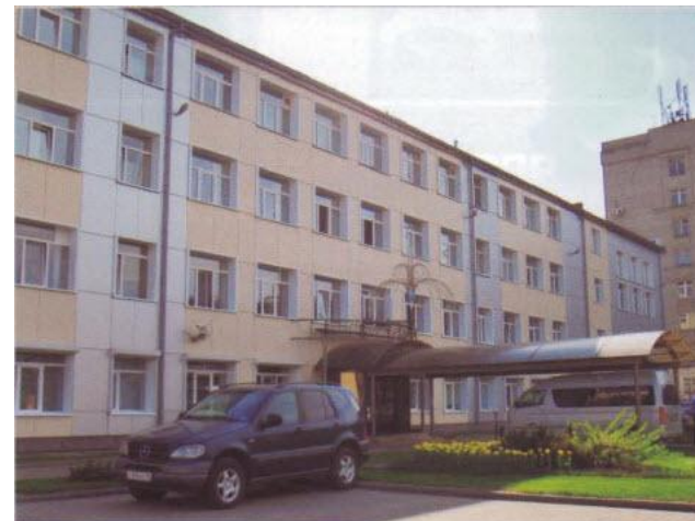
Фасад здания после реконструкции
