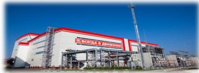
Краснодарская ТЭЦ, ПГУ – 410 МВт
