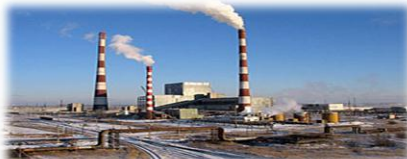
Красноярская ТЭЦ-3 – 208 МВт
