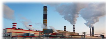
Киришская ГРЭС, бл. 6 – 540 МВт
